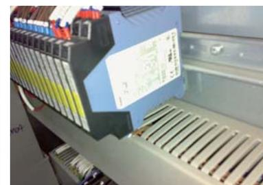
某钢厂西门子传动控制柜中大量使用 P27000 隔离器
