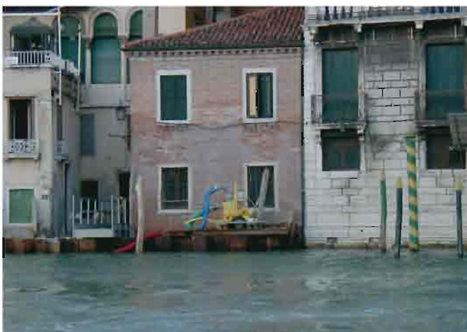
威尼斯的重建工程 Restoration work at Venice
